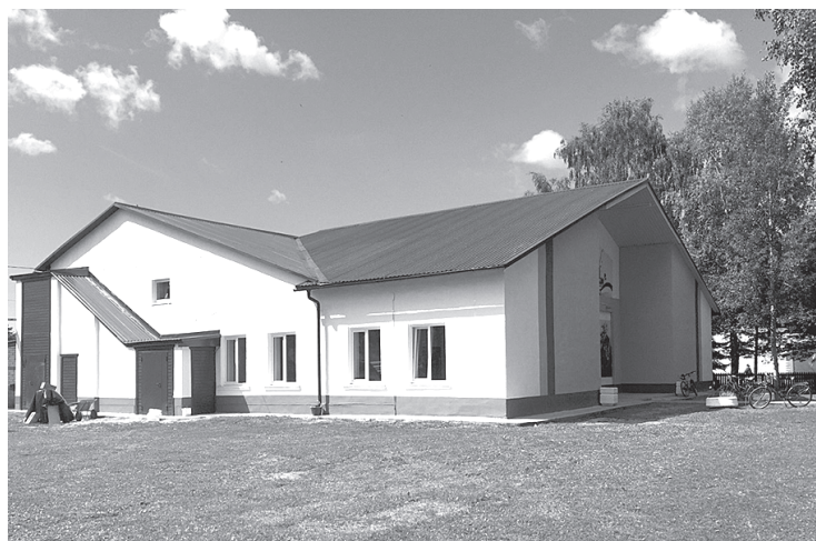
Талицкий сельский Дом культуры после ремонта.
