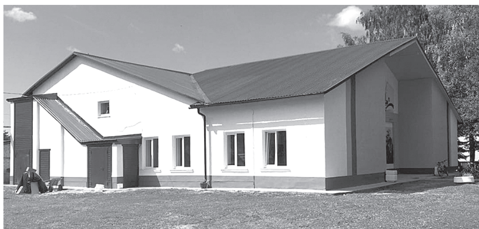
Талицкий Дом культуры после ремонта.
